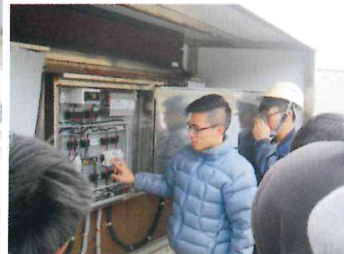
太陽光電設置乙級技能檢定練習
