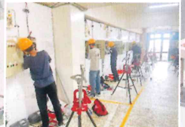
室內配線丙級技能檢定練習
