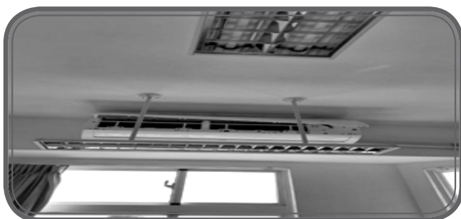
一對一分離式冷氣清洗濾網及檢查
