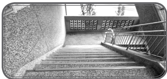
睿智樓各樓層樓梯增設止滑條
