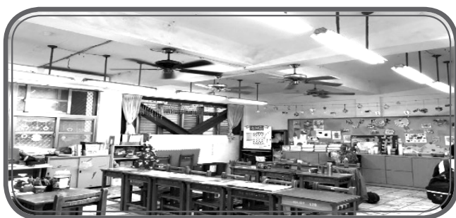
涵玉樓、游藝樓教室照明設備更新
